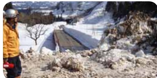
長野県北部地震：津南町辰ノ口土砂災害
